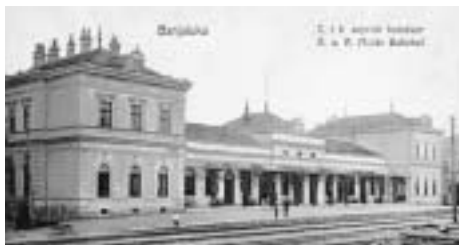
Banjalučki željeznički kolodvor gdje je stanovala obitelj Merz
